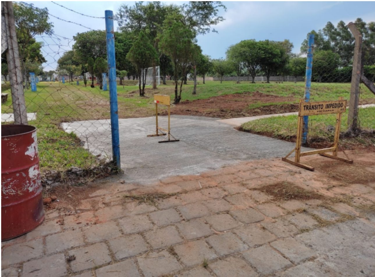
Entrada principal não atende as condições de acessibilidade (item 6.2.2 da Norma ABNT NBR 9050:2020)
