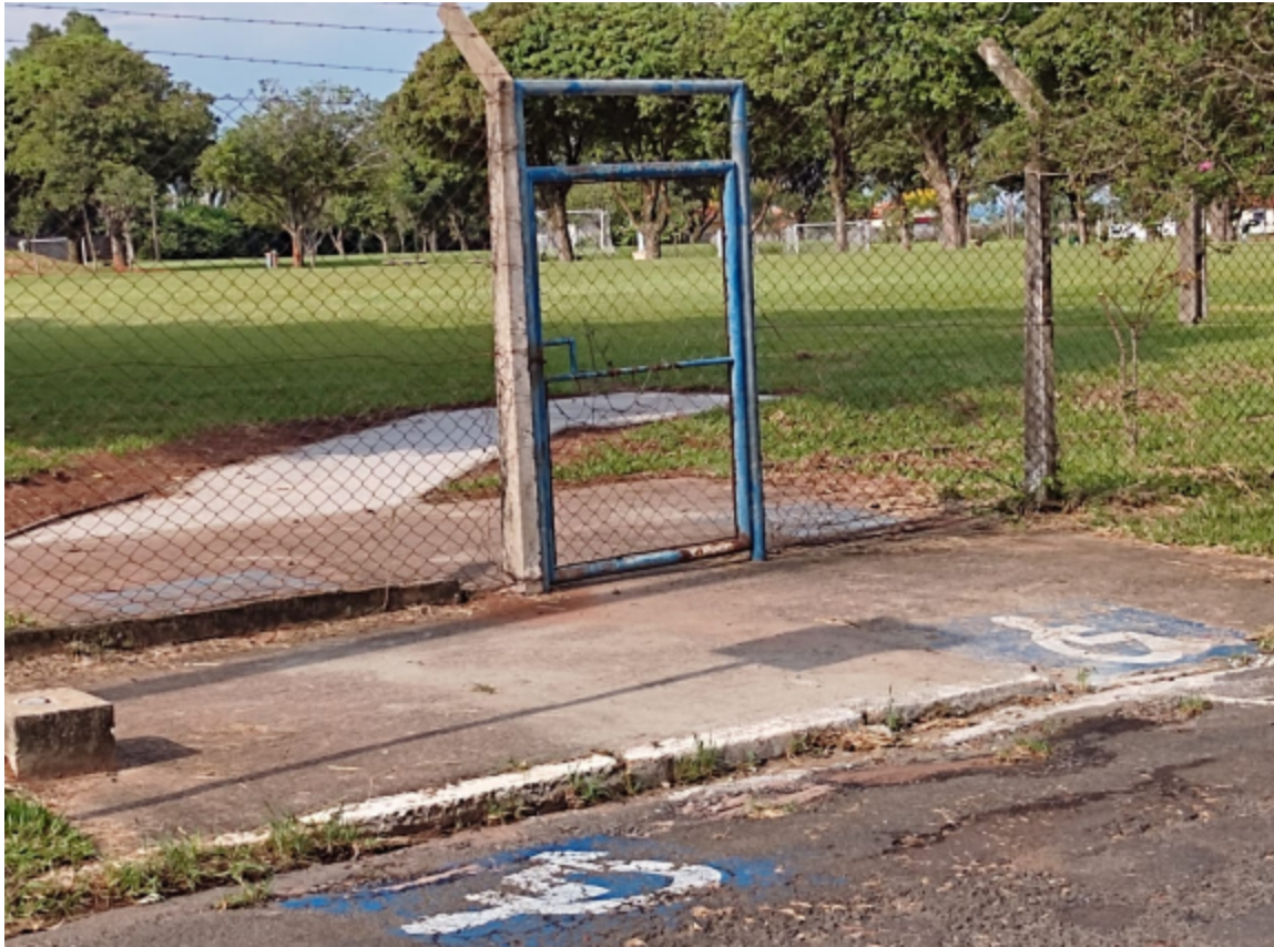
Entrada principal não atende as condições de acessibilidade (item 6.2.2 da Norma ABNT NBR 9050:2020)
